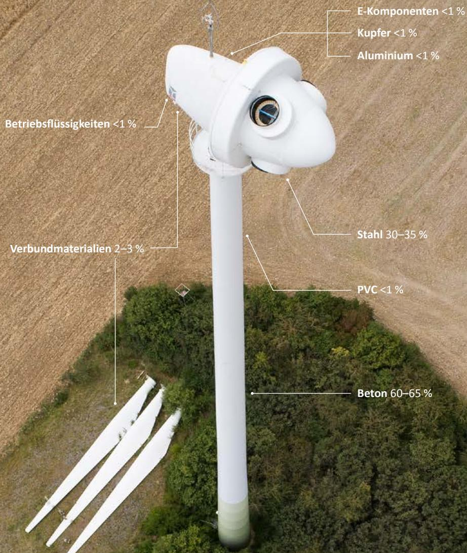
**Anteil der Baustoffe am Gesamtgewicht einer Windenergieanlage (in Prozent)**
