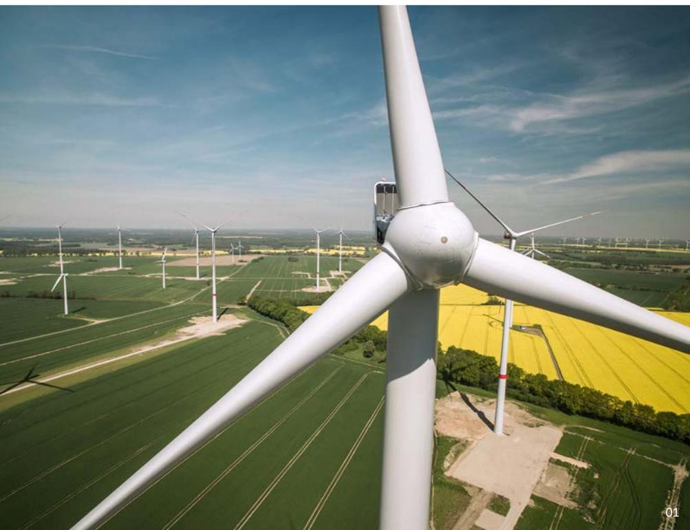
01 | Windpark-Repowering-Projekt Vormark/ Prignitz, Brandenburg: Nach Rückbau von Altanlagen Errichtung von 14 neuen WEA (Nennleistung 48,3 MW).
