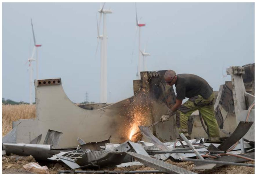
Rückbau und Zerlegung von Stahlteilen im Windpark Elisenhof Meerhof bei Paderborn.
