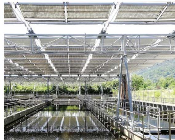
Solarfaltdachprojekte können ab einer Fläche von ca. 1.000 m<sup>2</sup> oder 120 kWp gebaut werden und sind beliebig skalierbar, dabei gilt es auf ein rechteckiges Layout zu achten. Die monokristallinen PV-Module sind wie Flachdachanlagen mit einem 10°-Winkel angestellt und erlauben so eine optimale Sonnennutzung unabhängig der Ausrichtung. Der Ertragsverlust durch Wind liegt in der Regel bei 3 % und für die Realisierung ist eine normale Baubewilligung zu durchlaufen.
