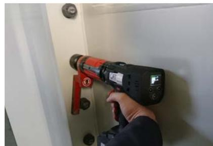
Vertikalflanschverschraubung im Turm mit sensorgesteuertem Akkuschauber MAD 7-S.
